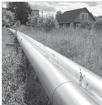
Так выглядят заизолированные наземные трубы по улице Молодежной: сверху - оцинкованный лист, под ним проложена тепловая изоляция.
