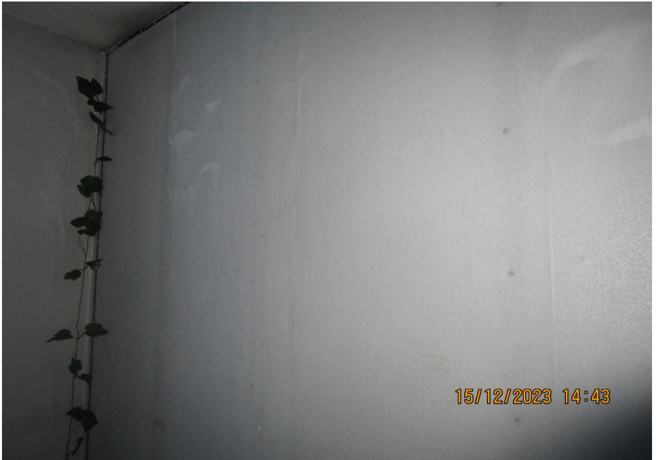
Фото №3. Закопчение продуктами горения поверхности конструкций. Разбухание листов ГВЛ, образование плесени на поверхности стен
