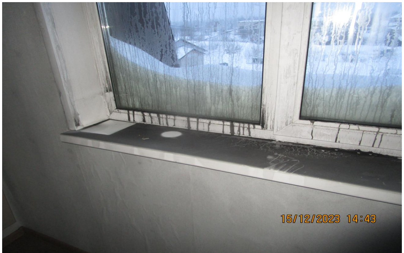
Фото №2. Закопчение продуктами горения поверхности стен, образование плесени на поверхности стен.
