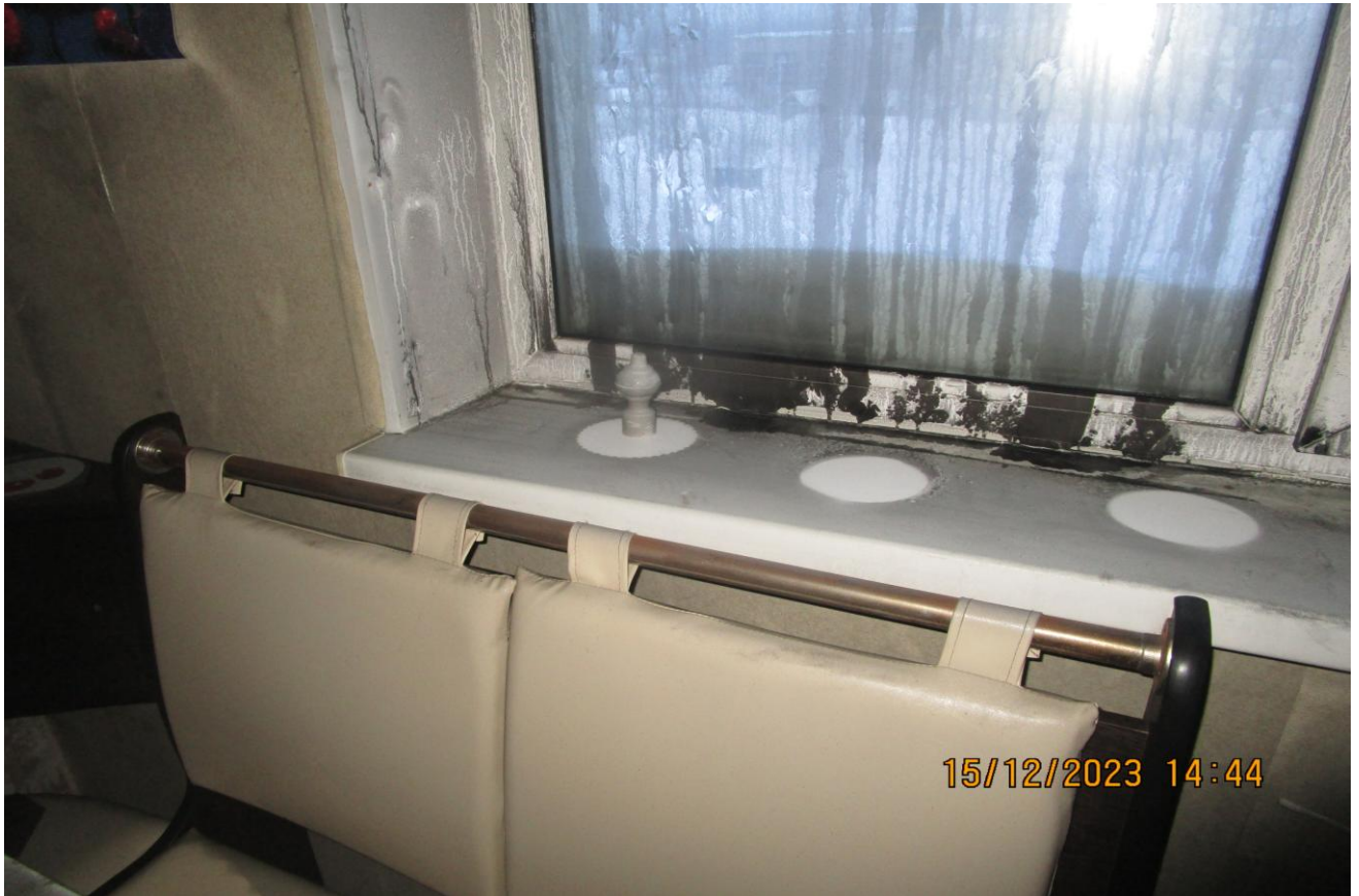
Фото №5. Закопчение продуктами горения поверхности стен, образование плесени на поверхности конструкций.
