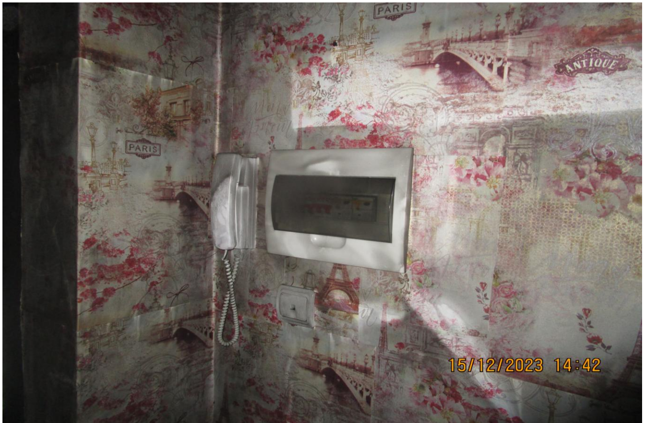
Фото 1. Закопчение продуктами горения поверхности стен, образование плесени на поверхности стен.
